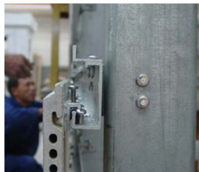
图 2 幕墙连接节点
